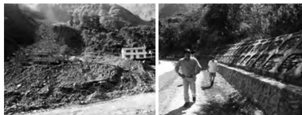
写真2 アラニコ道路の被害 写真3 シンズリ道路の被害
